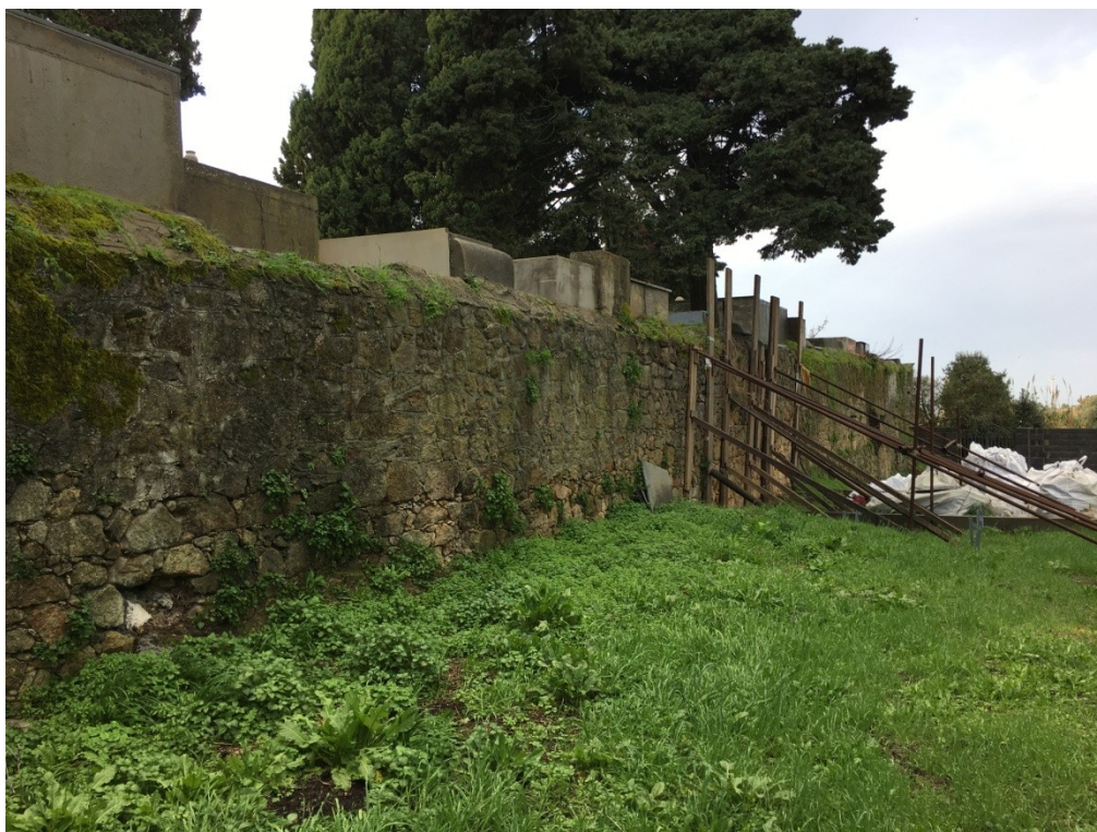
Scatto 1 – Veduta globale verso Ovest, situazione attuale
